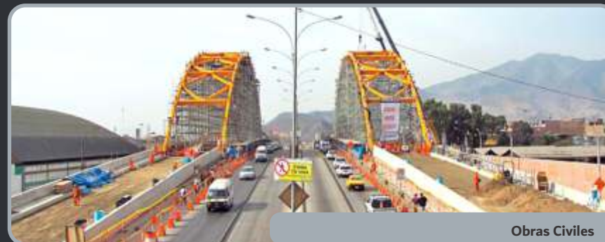
Demolición y Movimiento de Tierra
